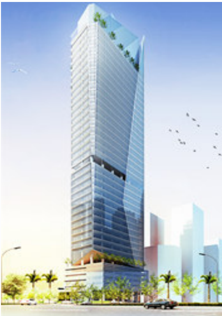
Gedung Perkantoran di Jakarta Selatan (Senopati)
